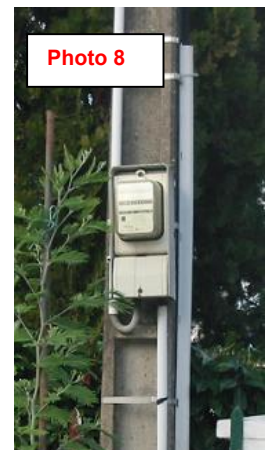
Compteur extérieur apparent
